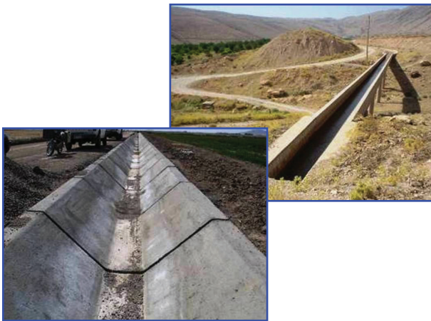
شکل ۲. استفاده از کانال‌های بتنی برای انتقال آب
